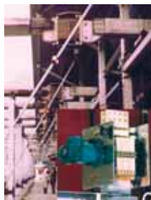
Разъединители большой мощности NORD диапазона. 1500В, DC от 14кА до 140 кА. Однополюсный / Двухполюсный / на 2 направления. Для производства меди, алюминия.
